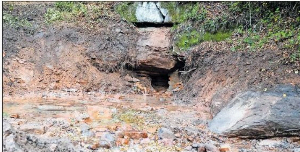
Am Saarbrunnen bei Ludwigswinkel rauscht und sprudelt das Wasser wieder, die Quellen wurden freigelegt, ein neuer Zugang zum Saarbach wurde angelegt.
