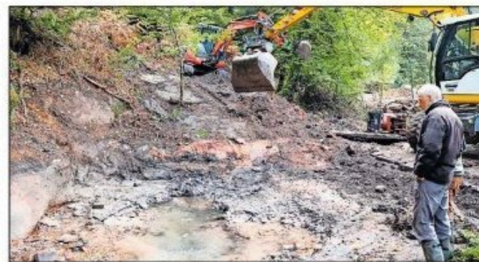
Das Quellengelände wird modelliert, Gewässerökologe Holger Schindler (rechts) verfolgt den Fortschritt der Arbeiten.
